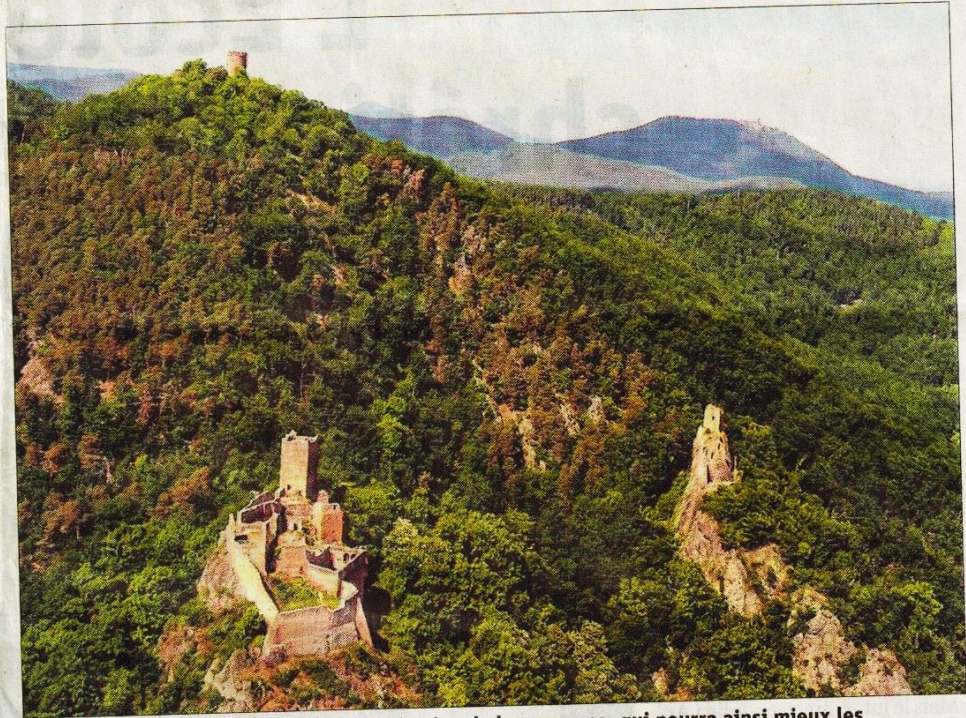
Les ruines font désormais partie du patrimoine de la commune, qui pourra ainsi mieux les entretenir. Photo archives DNA/Bernard SCHMIDLE
